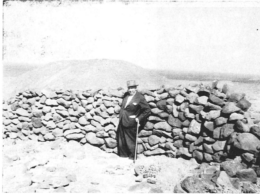
Fig. 51 - Un primer término de La Pared de Jandía, en Fuerteventura, con el autor como escala. Obsérvese el característico aparejo sin cuñas. Fot. Tarquis, 1959 (III, p. 234)
