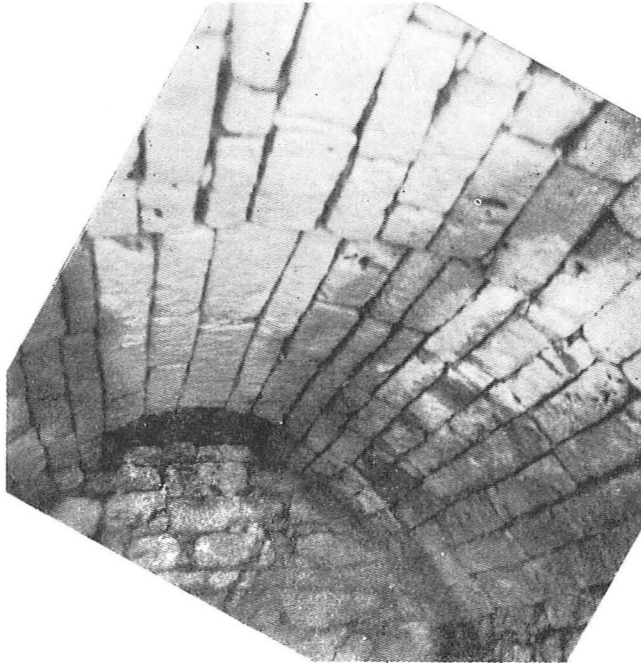
Figs. 19 y 20 - Lanzarote, interior y bóveda del aljibe del pozo primero de San Marcial, al pie del Castillo de Rubicón. Fotos J. Serra, obtenidas con flash, 1962 (III, págs. 202-3)
