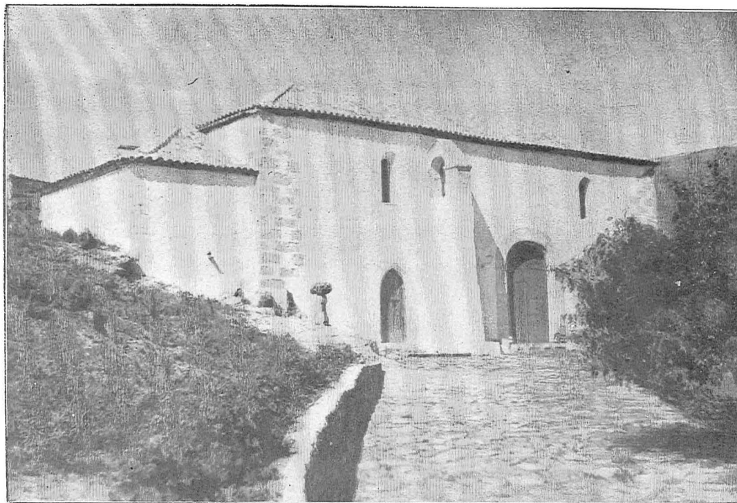
Ermíta de San Diego de Alcalá, levantada en el siglo XVII, sobre la gruta en que oraba el Santo, siendo Lego de la Menor Observancia franciscana, con destino en el Convento de San Buenaventura, de esta isla. Obsérvese la distinta estructura de sus dos puertas, la más pequeña de traza gótica, y la mayor, de arco de medio punto rebajado, lo que nos hace pensar en una sucesiva ampliación de la ermita, quizás a medida que aumentaba la devoción por el Santo
